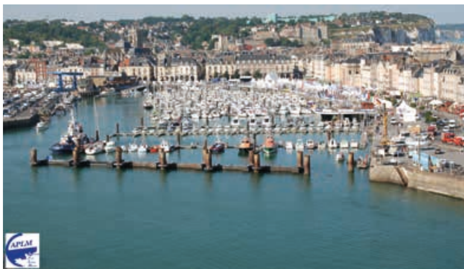
Port de Dieppe (© Nathalie Dumay / Association des Ports Locaux de la Manche)
